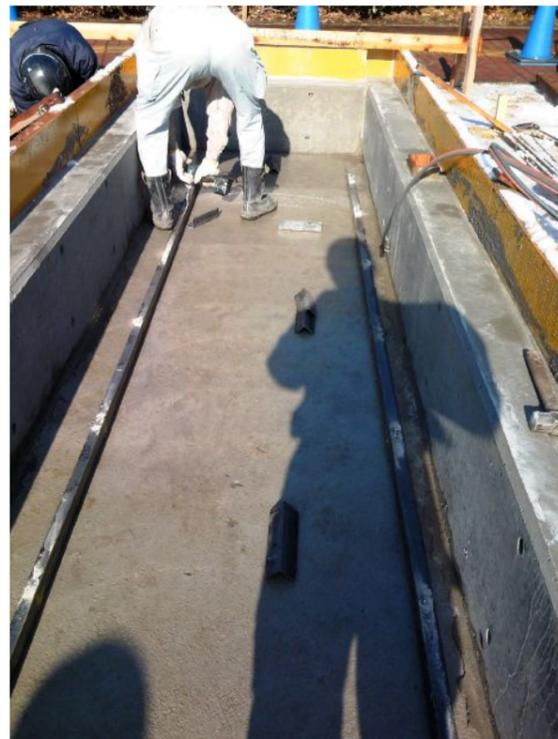
②アンカーボルトにてアングル材を固定する。
