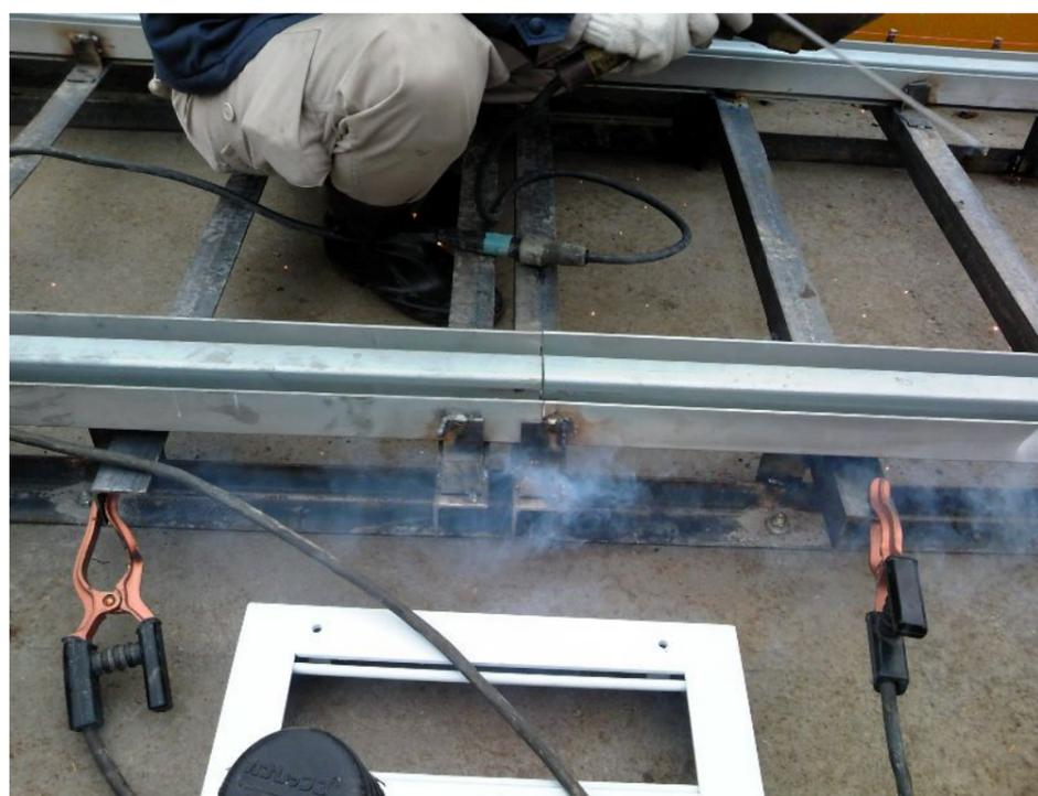
⑦溶接にて架台と固定。レベルを再度確認して溶接をする。
