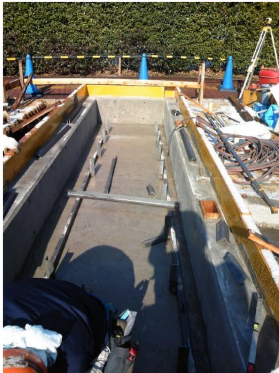
③レベルを出しながら柱、梁を溶接にて固定する。
