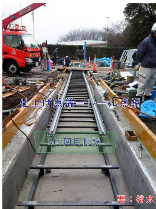
⑥架台にレールを載せる。クレーン作業にて設置
