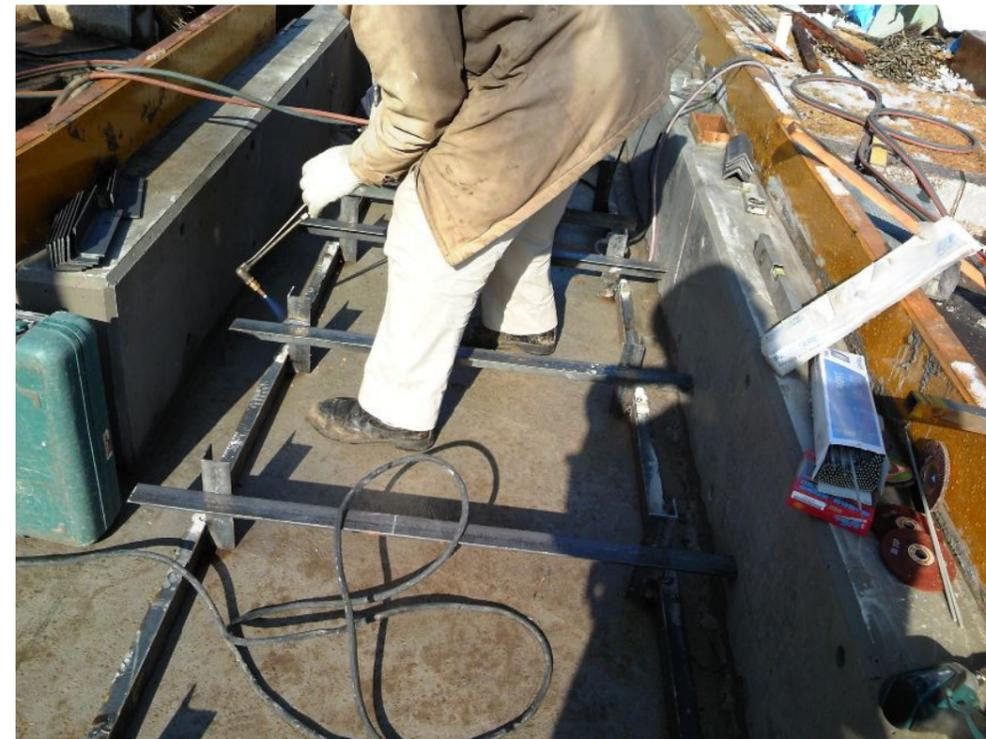
④レール受け用の架台の完成。梁を溶接後余分な柱材を切断する。
