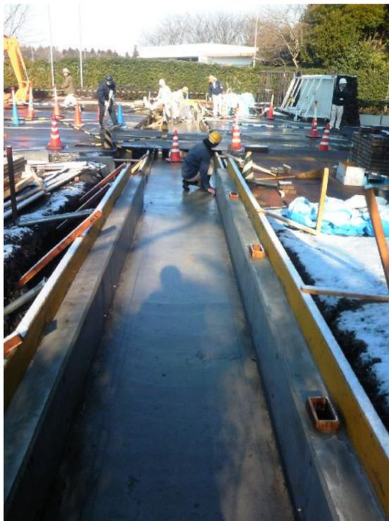
①配筋後RC打設後。ここにレールを取り付けます。
