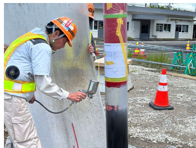
⑨ 塗装作業
