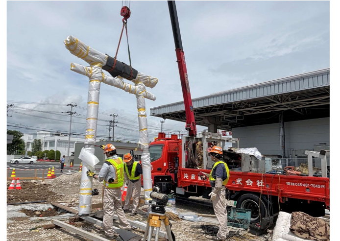
④ クレーン作業
